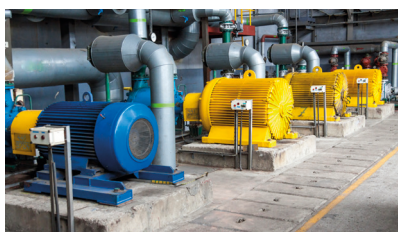
Installatie van machines
